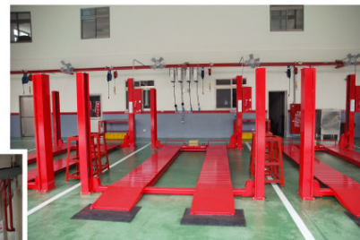
大型商用車頂車維修區
